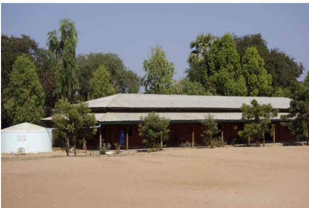
Manuel & Martin High School mit Regenwassertank
